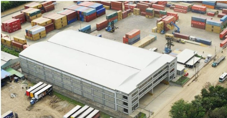
Bodega y Patio Contenedores Yumbo
