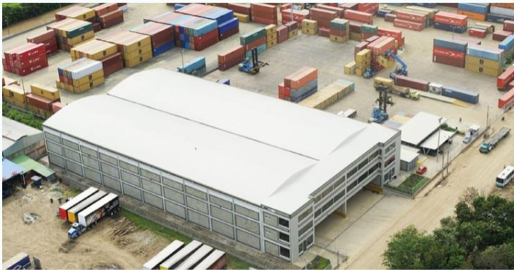
Bodega y Patio Contenedores Yumbo
