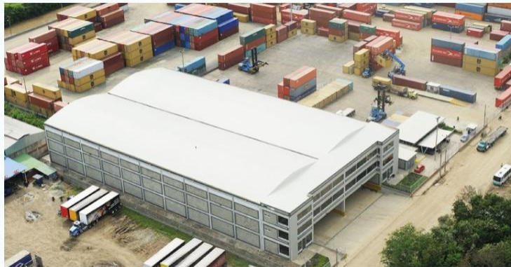
Bodega y Patio Contenedores Yumbo
